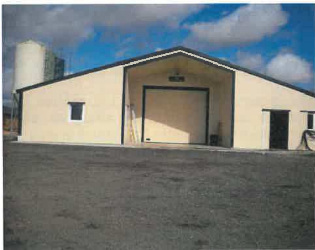
Zone bétonnée devant chaque pignon où s'effectue le chargement des volailles
